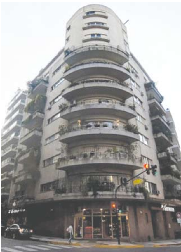
El edificio Minner, en el barrio de Retiro, es una creación de los arquitectos húngaros Jorge y Andrés Kalnay.
